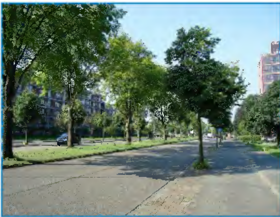
Foto 3. Prins Bernhardlaan; iepen aan zijkant zijn in slechte conditie, bomen vervangen in combinatie met goeiplaatsverbetering.
