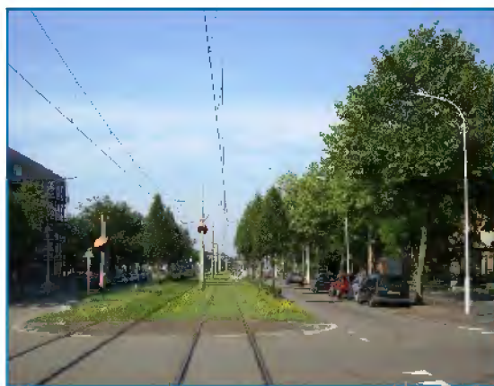
Foto 4. Mgr. Van Steelaan t.h.v. Irenelaan. Geschoren haagbeuk te breed voor bovenleiding tram.
