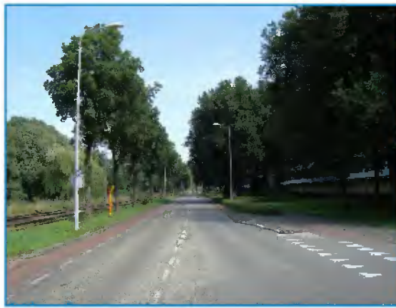
Foto 4. Aan rechterzijde weg enkele iepen te dicht op de flats.
