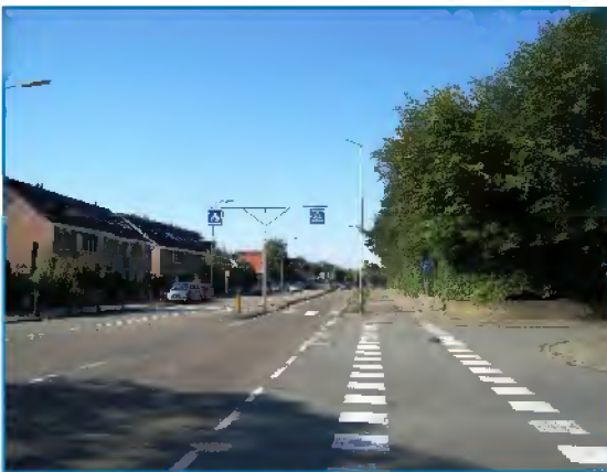
Foto 4. Veursestraatweg nabij Noordsingel. Ruimte maken voor laan in het kader van een wegreconstructie.
