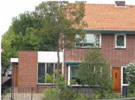
voldoet, verwant aan de stijl van de woning
