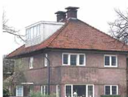
het dichte deel zit niet tussen maar onder de ramen, bovendien is de dakkapel te hoog.
