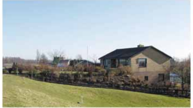
deze woning staat op ruime afstand van de kruin van de dijk. Het voorerf is opgehoogd tot aan de kruin. Dit "aanterpen" verstoort zowel de openheid van het landschap als wel het kenmerkende doorgaande dijkprofiel en wordt door welstand afgewezen.
