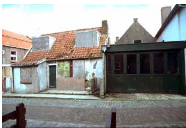
Verkrotting, dichtzetten van gevelopeningen, etc.
